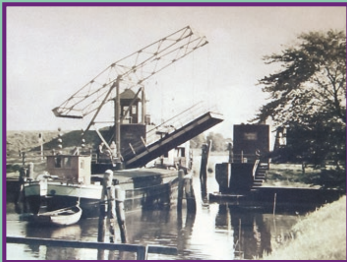
Seite 50 – Schleuse Kasenort, ein Erlebnis- und Informationspunkt am Gezeitenstrom Foto: Arno Kruse
