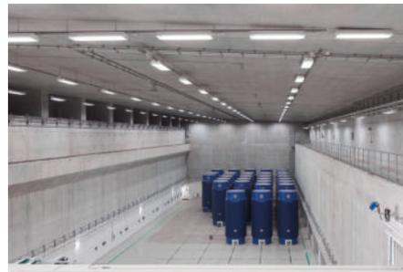
**Zwischenlager Brokdorf, am Ende stehen hier voraussichtlich 84 Castor-Behälter, Foto: BGZ**
